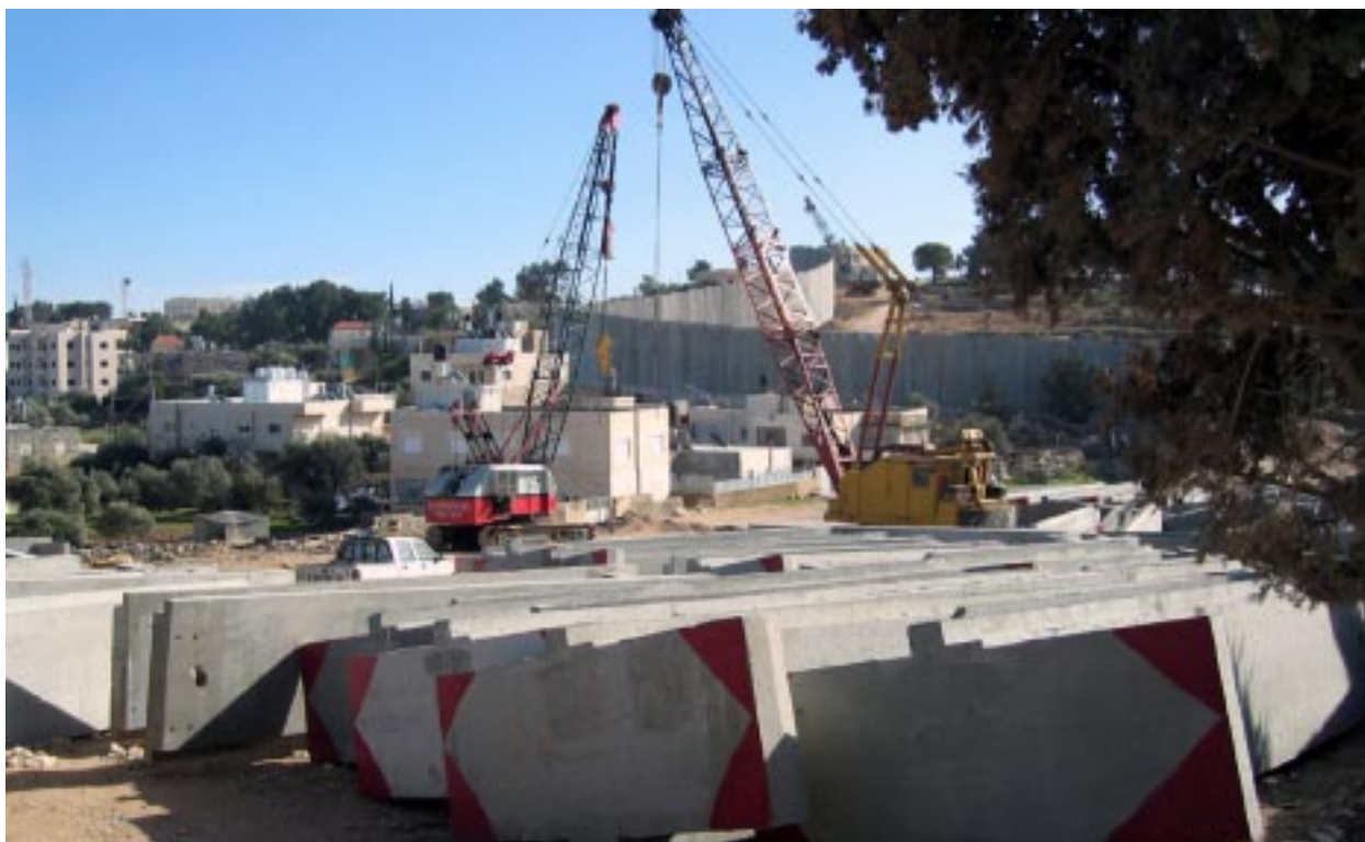
Bygget av muren pågår rakt genom samhället Abu Dis, utanför Jerusalem.
